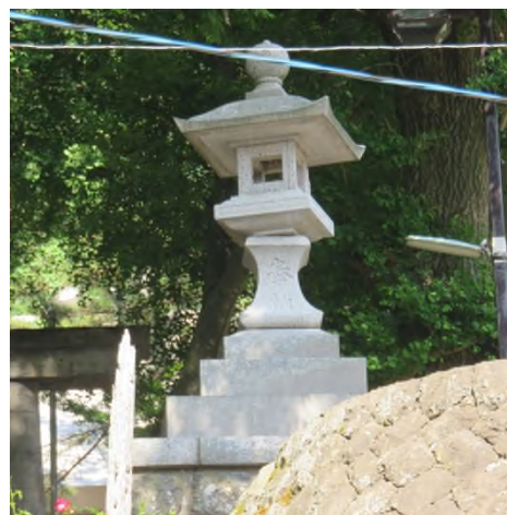
図 2-12 熊野神社の階段上の灯籠の回転 階段は使用不可となっていた
