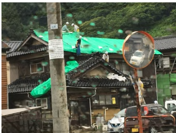
図 2-4 鶴岡市小岩川の民家の屋根にシートをかぶせる作業中。応急危険度判定は要注意（黄色）
