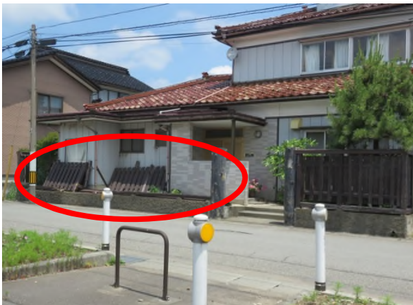
図 2 - 31 木造の塀の倒壊
