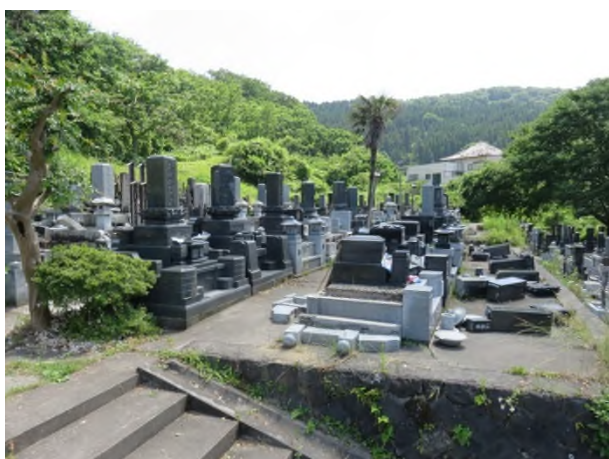
図 2-18 墓石の転倒 盛土面上の墓石は全て倒れているが、それ以外では全く倒れていない。
