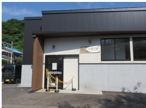
図 2-5 小岩川駅の駅舎は立入禁止
