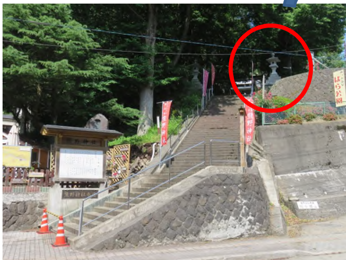
図 2-12 熊野神社の階段上の灯籠の回転 階段は使用不可となっていた
