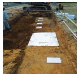
空洞モデル施設工事の様子
