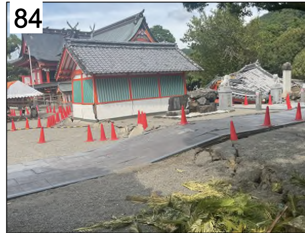
八代市妙見町の八代神社（妙見宮）にあらわれた地震断層。 右横ずれ95cm，東上がり40cmの断層変位が認められる。 地震断層は写真左奥の本殿の西側を通過して，神社の南に 隣接する木山商店まで連続している。 写真右の楼門は地震動により倒壊している。8月1日撮影
