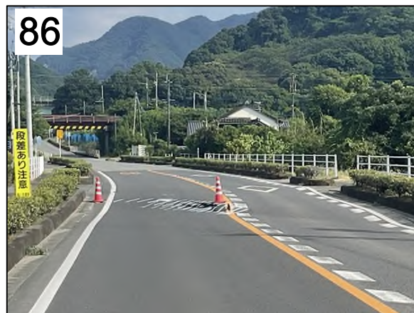
八代市豊原上町の国道219号線舗装の断層変位。変位量は、右横ずれ20cm，東上がり15cm。地震断層は写真右側（南西側）の田地に連続している。8月1日撮影
