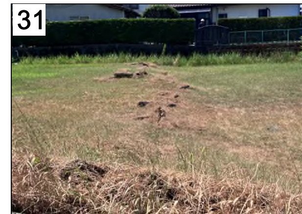
宇城市小川町北部田にあらわれた地震断層 7) . 写真左の東側が約32cm隆起しており, 短縮変形による構造物の座屈が認められる. 雁行亀裂が発達し, 写真奥の民家の直下を通過する. 8月2日撮影.
