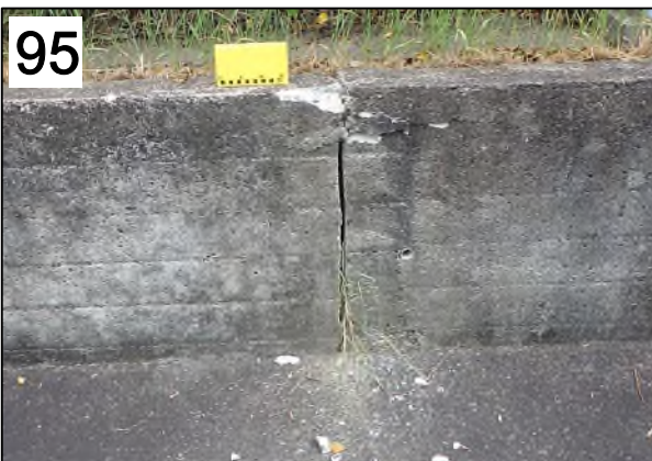
八代市平山新町の中九州短期大学の擁壁のクラック。 幅約2cmで開口している。 明瞭な横ずれおよび縦ずれ変位は認められない。 8月4日撮影。
