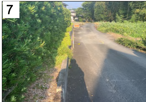
御船町高木のブロック塀の右横ずれ 7) 。2016年地震とその後余効すべりにより、本地震の以前から5 cm程度の累積変位が認められていたが、本地震でも再び変位した。累積変位は約17cm、塀の屈曲が認められる。8月2日撮影。
