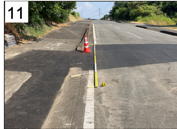
御船町滝川の道路を横切る地震断層 7) 。道路白線が18cm右横ずれ変位しており、写真手前の西側がやや低下する。断層があらわれた位置は地震後に舗装されている。8月2日撮影。
