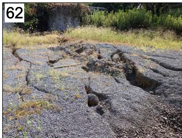
氷川町野津。雁行状にクラックが配列する。右横ずれ百数十cm, 縦ずれ約30cm (東側隆起)。8月5日撮影。
