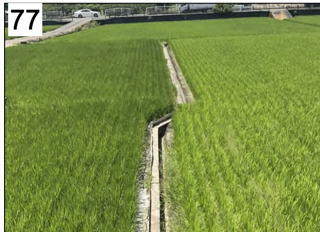
八代市川田町東にあらわれた地震断層。写真中央の水路に右横ずれ110cm, 東上がり30cmの断層変位が認められる。写真奥に見られる車両は国道3号線。8月1日撮影
