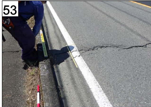
53 氷川町野津の国道3号を横切る地震断層。 2cmの右横ずれ変位。8月5日撮影。
