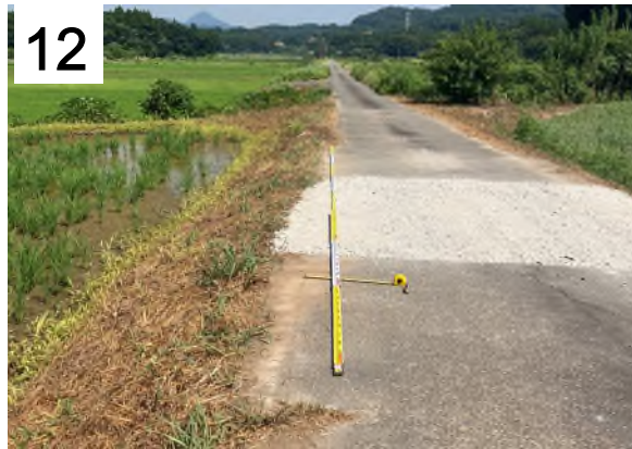
熊本市南区城南町鰐瀬の道路を横切る地震断層 7) 。道路舗装を基準として約18cmの右横ずれ変位が認められる。8月2日撮影。
