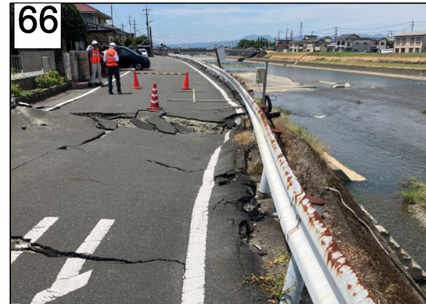
氷川町宮原の道路を横切る地震断層 7) 。道路白線を基準として右横ずれ約120cm。8月1日撮影。
