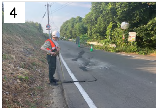
御船町高木のアスファルト路面にみられる雁行亀裂群 7) 。写真右の南東側が相対的に低下する。2016年地震とその後の余効すべりでも雁行亀裂が認められ、本地震でも同様の位置に亀裂が生じた。8月2日撮影。
