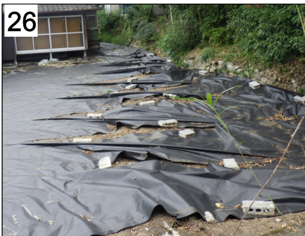
宇城市小川町南小野の畑地を横切る地震断層。8月7日撮影。
