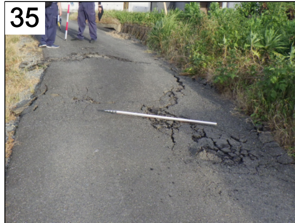
宇城市小川町南部田の道路を横切る地震断層、右横ずれ約30cm、8月6日撮影。
