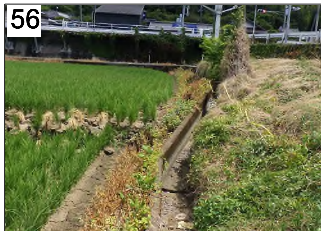
56 氷川町野津の用水路および水田を横切る地震断層。 右横ずれ139cm, 縦ずれ48cm (写真奥の東側隆起) 8月5日撮影。
