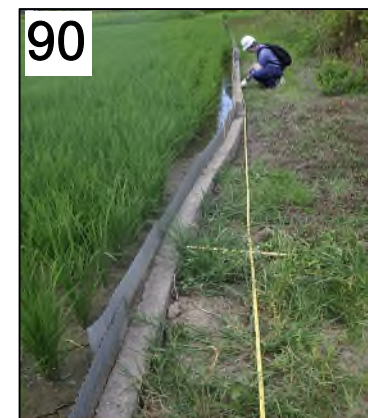
八代市豊原下町の水田を横切る地震断層。右横ずれ36cm（水田擁壁は地震前から曲がっていた可能性あり），縦ずれ数cm（写真手前の東側隆起）。水田内の水は西側に滞留している。8月4日撮影。
