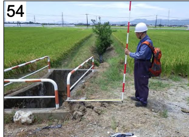
54 氷川町野津の用水路を横切る地震断層。 右横ずれ108cm, 縦ずれ37cm (写真手前の東側隆起)。 8月5日撮影。
