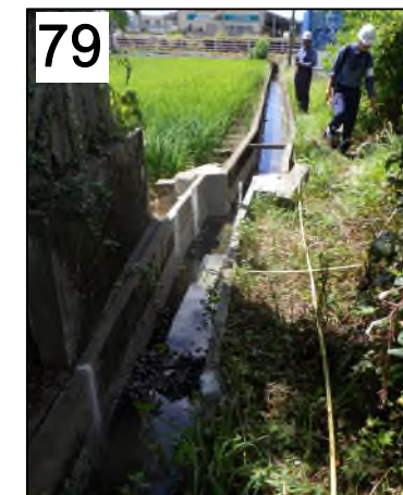
八代市東片町の水田を横切る地震断層。右横ずれ51cm。8月6日撮影。
