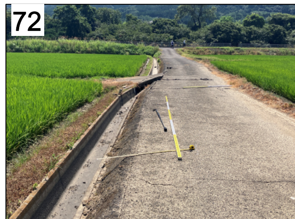
八代市岡町の水田の道路を横切る地震断層 7) 。道路脇の側溝を基準として右横ずれ約110cm。地震断層は雁行状に配列して水田を横切る。上下変位は小さい。8月1日撮影。
