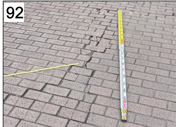
八代市平山新町のタイルの右横ずれ。 変位量は1cm程度。8月4日撮影。
