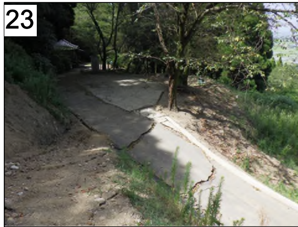
宇城市小川町中小野の道路を横断する地震断層。複数のクラックが認められる。右横ずれ25cm, 縦ずれ10cm (西側隆起)。8月7日撮影。
