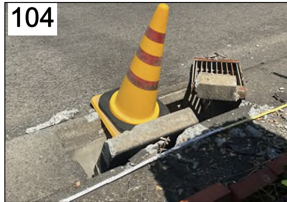
104 八代市場町の道路側溝の変状。 コンクリート蓋が破壊され、グレーチングが跳び出している。U字溝と手前のレンガ枠に1cm弱右横ずれが認められる。写真97～100にかけて、亀裂・地割れの分布は幅400～500mにブロードに広がる。8月18日撮影。
