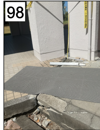
八代市平山新町の熊本高等専門学校八代キャンパス図書館の隅柱の損壊。右横ずれ変位により、管理棟と連結するペデストリアンデッキの柱（写真左側）との間が約5cm開いている。8月18日撮影。
