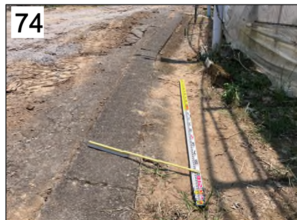
八代市川田町の舗装路面の右横ずれ 7) 。 約30cm右横ずれし、上下変位は約30cm（写真奥の東側隆起）。 8月3日撮影。
