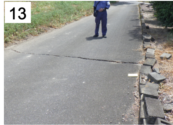
熊本市南区城南町鰐瀬の道路を横切る地震断層。右横ずれ15cm。道路両側の畑地にはN60E方向にクラックが発達している。8月7日撮影。
