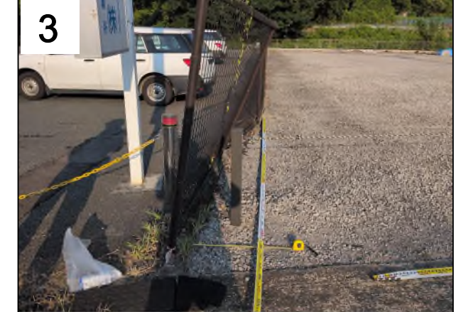
御船町高木のフェンスの右横ずれ 7) 。2016年地震とその後の余効すべりにより本地震の以前から変位が認められていたが、本地震でも再び変位した。フェンスの屈曲と舗装路面の雁行亀裂が認められる。8月2日撮影。
