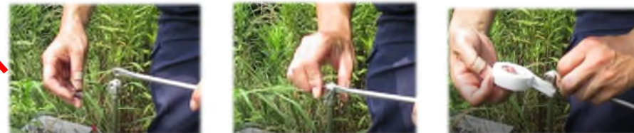
ジョイントクランプの接続方法 (ビニールテープ)
