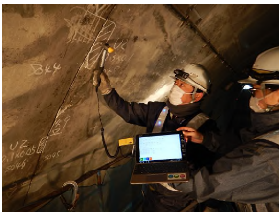
打音調査の様子
