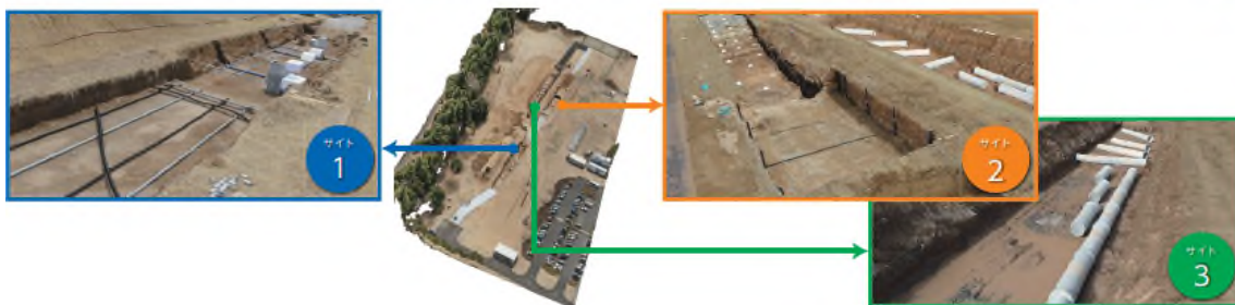
道路下への埋設管敷設状況
