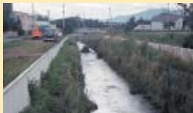
改修前の三面張りの河川
