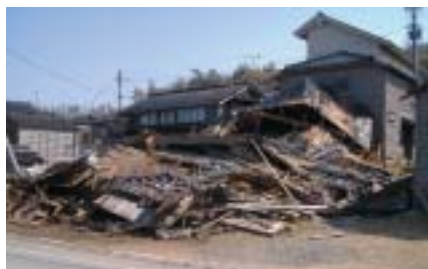
能登半島地震の被害事例
