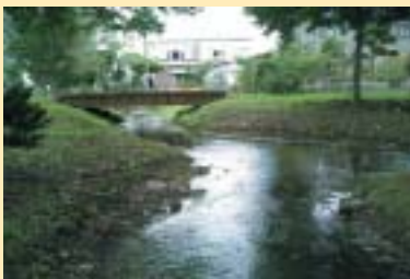
改修後の水辺空間
