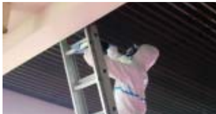
アスベストの調査状況
