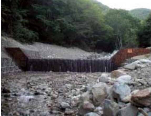
当社の考案による間伐材を利用した構造物 「メンテナンス対応型ハイブリッド木製堰堤」
