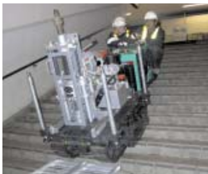
狭く、階段の多い駅構内や市街地での作業に役立つ 階段自走昇降型ボーリング装置「かいだん君」
