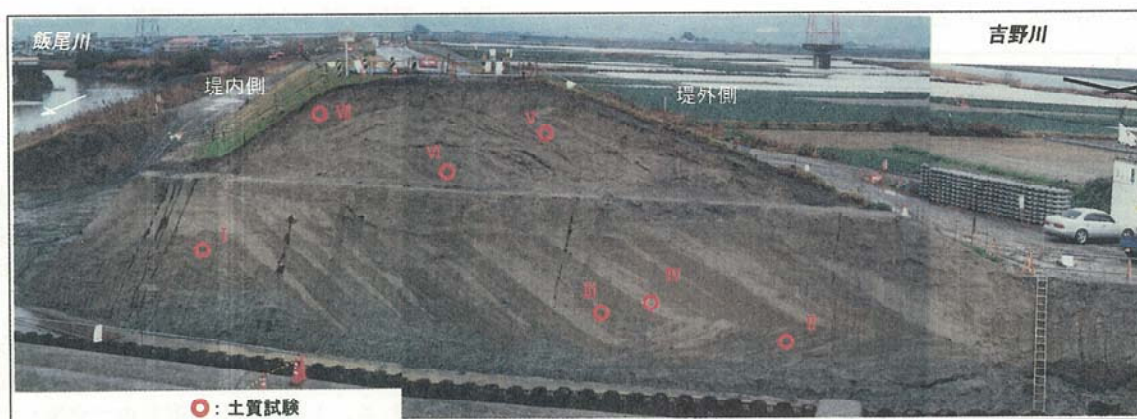
写-2 開削断面全景
