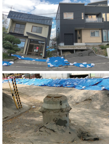
液状化による被害状況 (北海道胆振東部地震：2018年)
