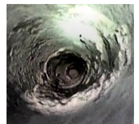
煙突内部の劣化状況確認
