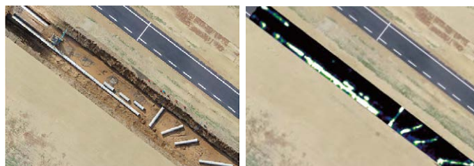
埋め立て前の状況
