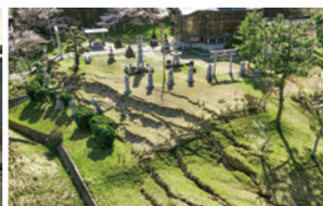
そくほう 液化化被害（地盤の側方流動）
