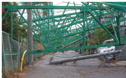
2019年9月 台風 15 号による被害状況 (千葉県での電柱などの倒壊)
