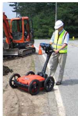
■ 工事現場における埋設物調査
