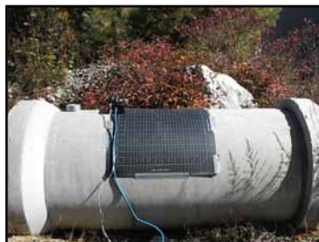
■ ヒューム管での測定例
