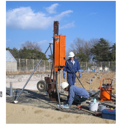
ラムサウンドによる設置作業状況
