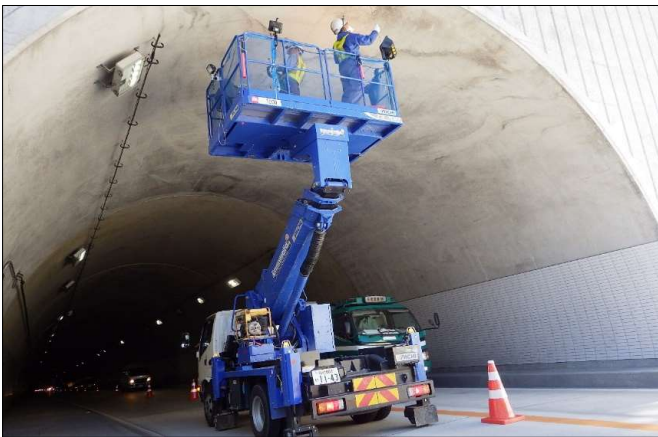
トンネルの点検
