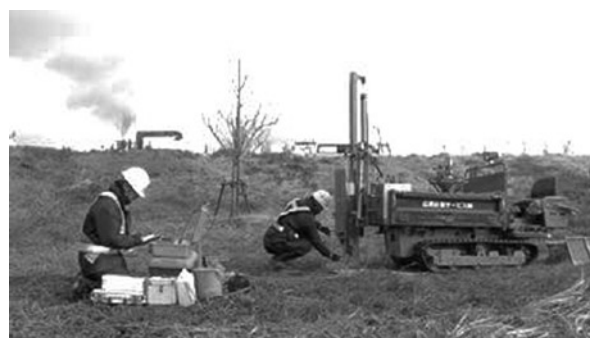
写真-4-3 ミニラムクローラー搭載型の装着状況 Photo. 4-3 PDC of lightweight ram sounding on crawler type base machine
