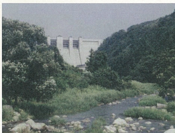
図-2 三春ダム堤体及び下流河川
