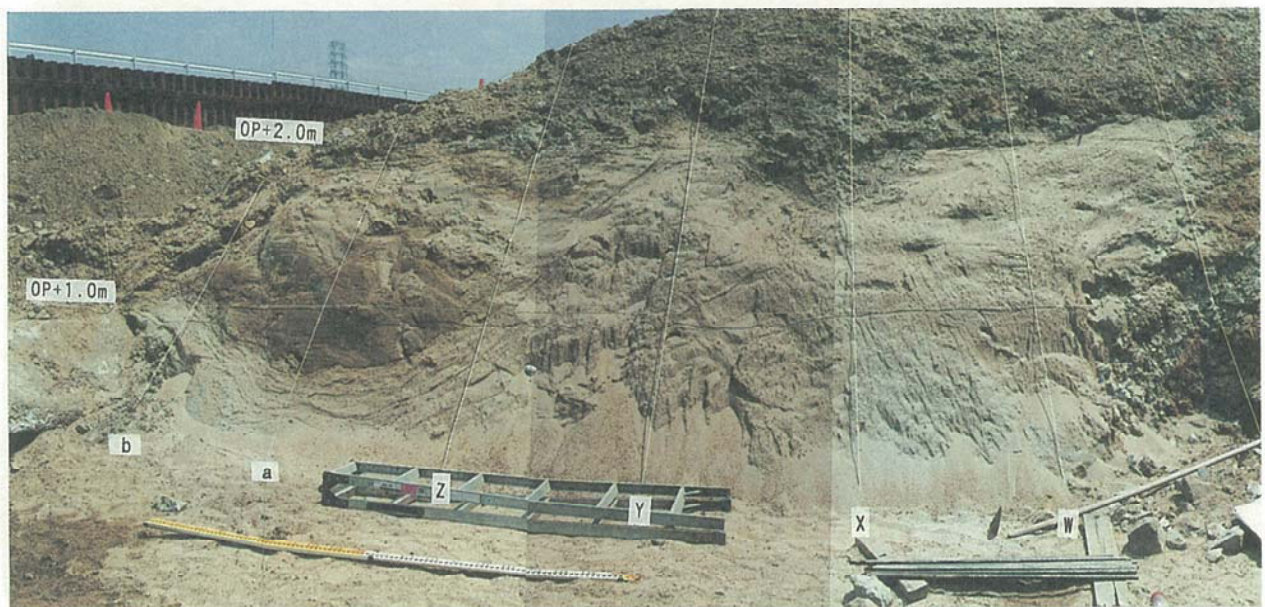
写真-7 距離標1.0km断面における川表側の砂脈の詳細
