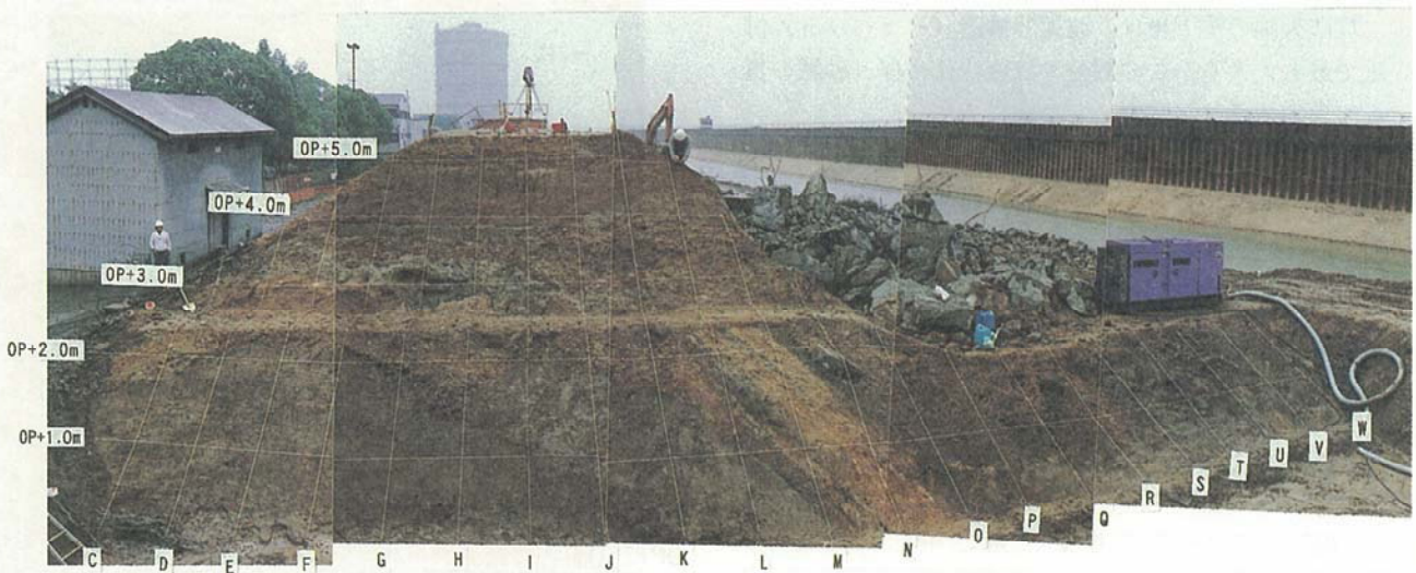
写真-9 距離標1.4kmの開削断面
