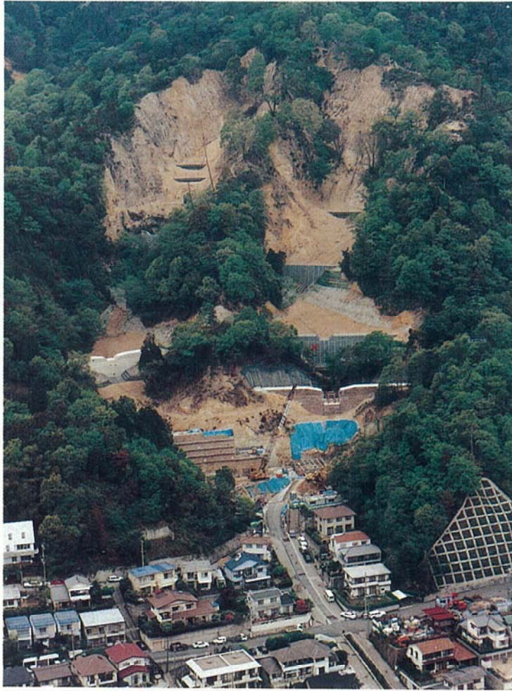
神戸市灘区、西谷山の山腹崩壊。やせ尾根を狭んで両沢の斜面が広範囲に崩壊した。
