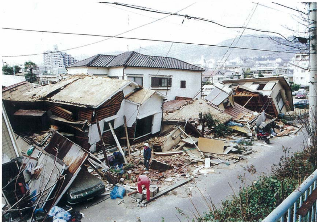
神戸市灘区、木造建物の被害状況。被害のなかったものも見る事ができる。
