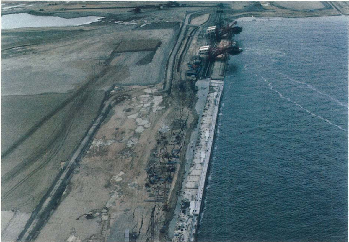
神戸市中央区ポートアイランド、液状化による新しい埋立護岸のはらみ出しと護岸裏の沈下、亀裂。
