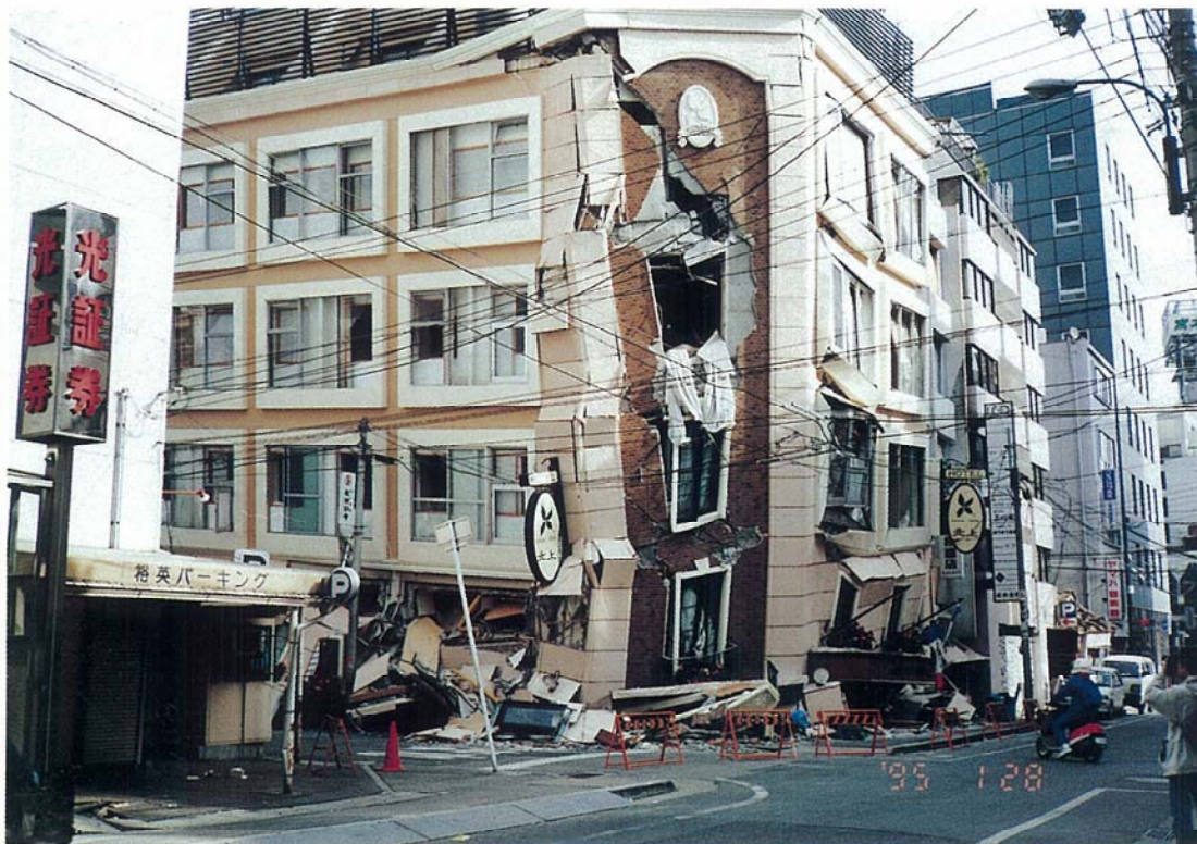
神戸市中央区、ホテルの低層および道路向きの1階角部分がくずれた。
