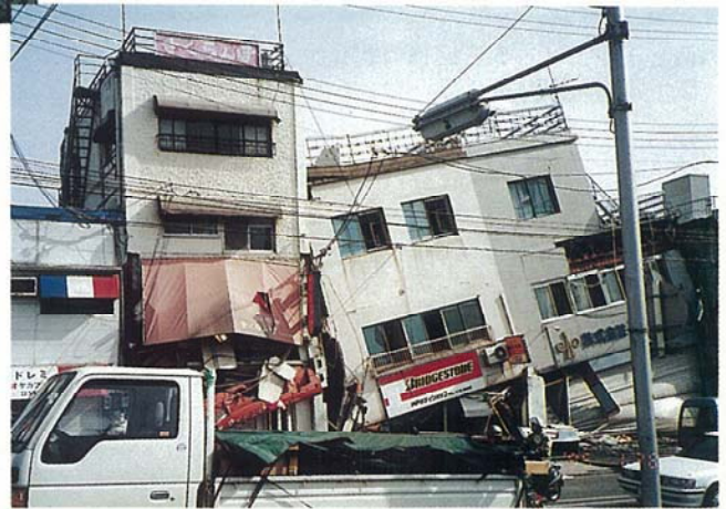
神戸市長田区、木造建物の1階部分がつぶれた。
