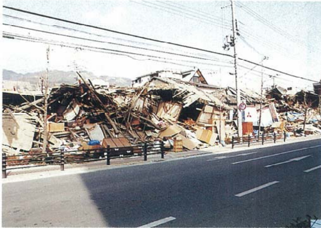
神戸市東灘区、国道2号沿いの木造建物の倒壊状況
