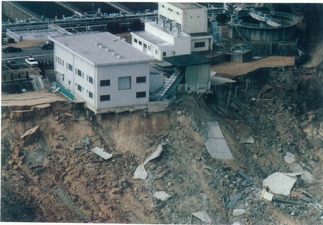
西宮市仁川、浄水場脇の崖くずれの状況。民家10数戸が埋没した。
