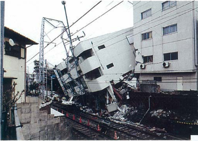
西宮市相生町、S造建物の低層がくずれて、 阪急電鉄の線路をふさいだ。
