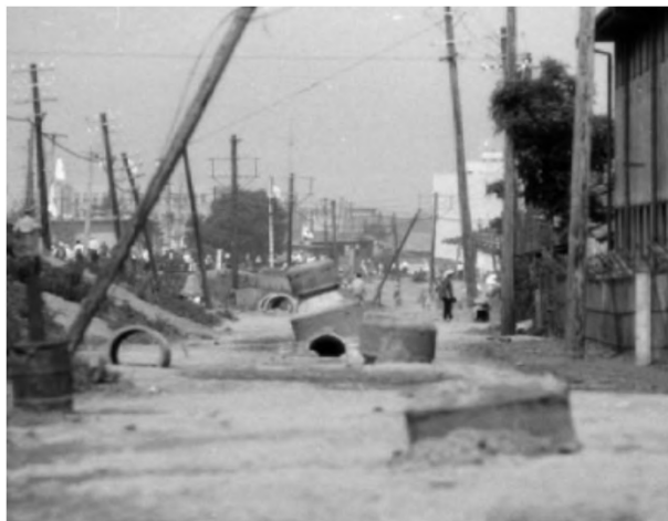
マンホールの抜け上がり
