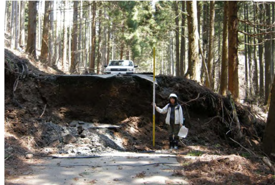
井戸沢断層(福島県いわき市内陸部) 平成25年4月11日 M7.0の地震で地表 地震断層(正断層)が出現
