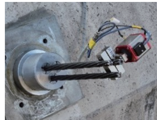
アンカー頭部への加振機設置
