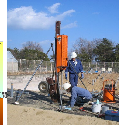
ラムサウンドによる設置作業状況
