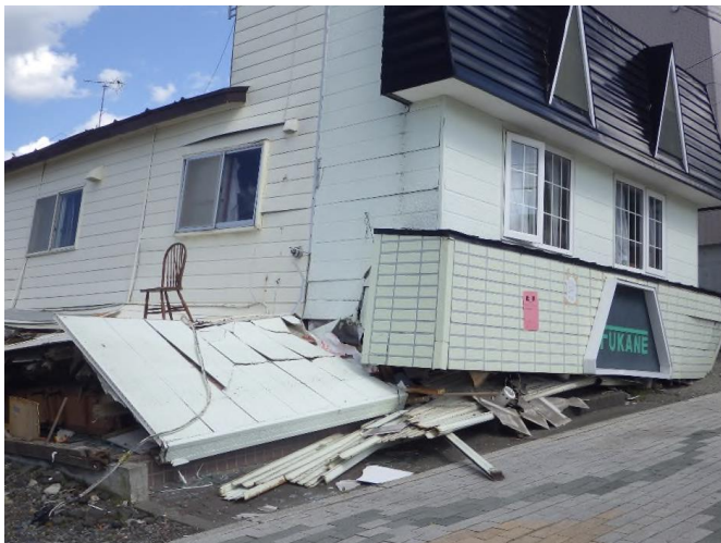
鷺川 店舗併用住宅の被害
