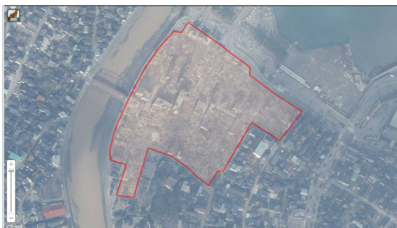
図4-3 輪島市中心部の火災焼失範囲(赤線の範囲内)
