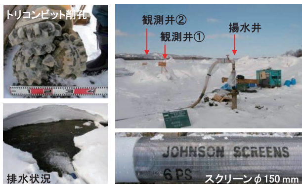
図-8 揚水試験状況 Fig. 8 Production test situation
