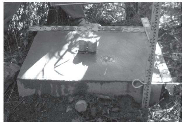
図-12 データロガー他収納部基礎設置状況
