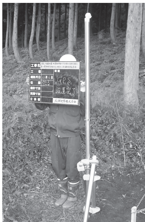
図-16 GPS設置状況
