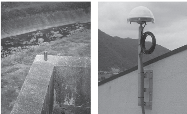
ボルト (保護キャップ付) Bolt (with protect cap) 取付金具 /GPS アンテナ Bracket/GPS antenna
