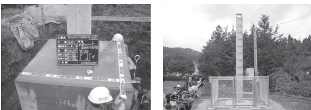
図-18 基礎形状とGPS 設置状況
