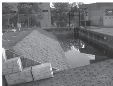
写真-3 湛水実験地の遠景
