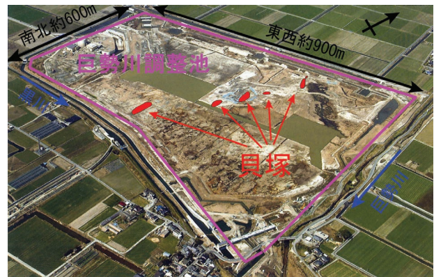
写真-1 巨勢川調整池航空写真 2)
