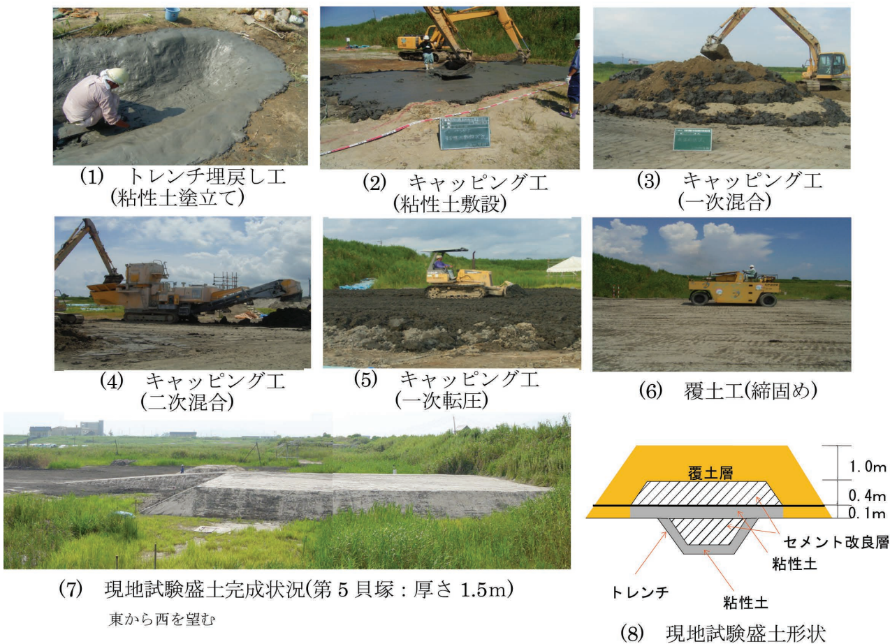
写真-2 試験施工状況(第5貝塚)
