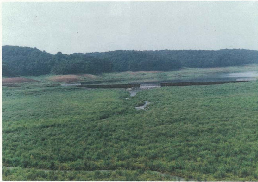
写真-1 上流部の締切の状況（北側）1998年撮影 Photo.1 The closing of water flow (north side).
