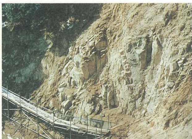
写真-6 斜面の緩み状況。表面に近いところでは割れ目が少し開いている。
