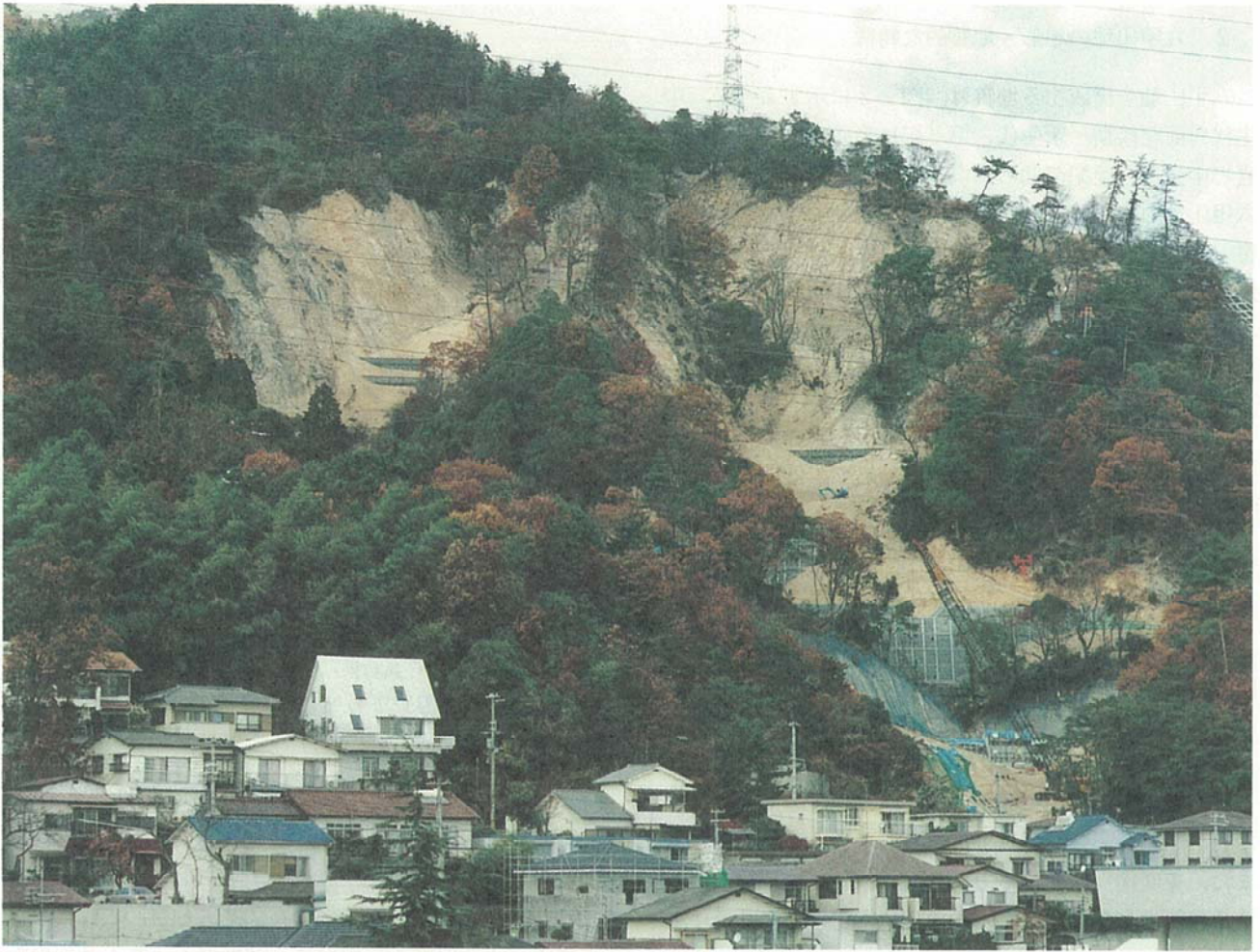
写真-1 西谷山崩壊地全景
