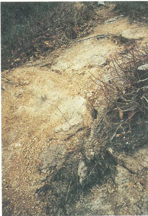
写真-3 法肩部に発生しているクラックの状況。 Photo 3. Cracks around the shoulder of the mountain.
