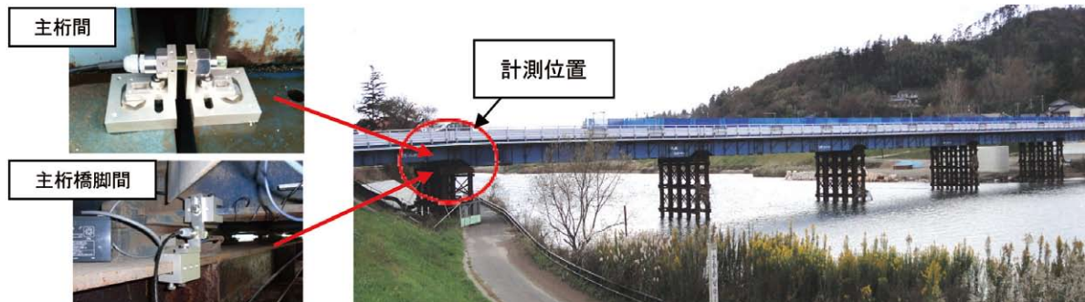
写真-3 仮設橋外観およびセンサ取り付け状況
