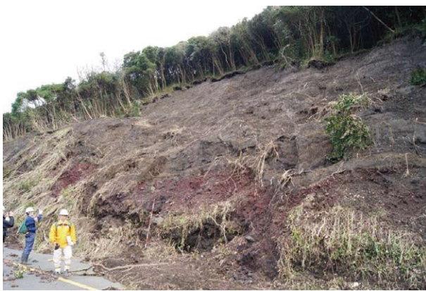
写真-3 道路沿いの斜面の表層崩壊 (③地点) Photo 3 Slope collapse along the road (Site ③) 赤褐色のスコリア層には植生が残っており、表層崩壊範囲はこの上の斜面にあたる
