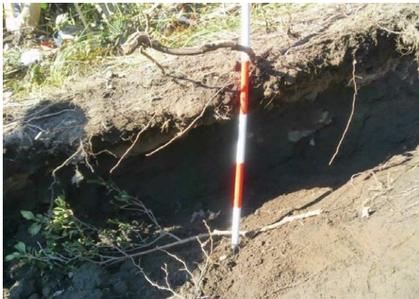
写真-9 崩壊地側部の状況 Photo 9 Side of collapsed area
