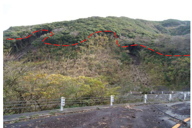
写真-1 遷急線付近の表層崩壊と植生 (①地点) Photo 1 Slope collapse and vegetation around the knick line (convex Site 1) 遷急線（赤破線）付近で左右に表層崩壊がみられ、中央は崩壊跡地でヤシャブシなどの植生が繁茂している。
