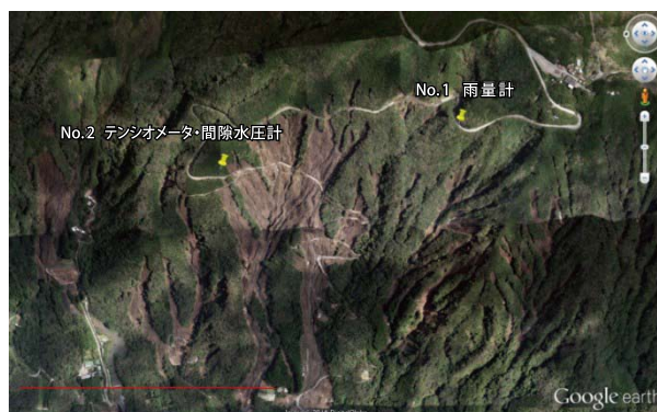
図-13 崩壊地とモニタリング計器設置場所 Fig. 13 Collapsed area and locations of monitoring instruments
