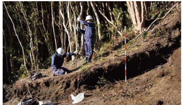
写真-10 簡易動的コーン貫入試験実施状況 Photo 10 Portable dynamic cone penetration test in progress
