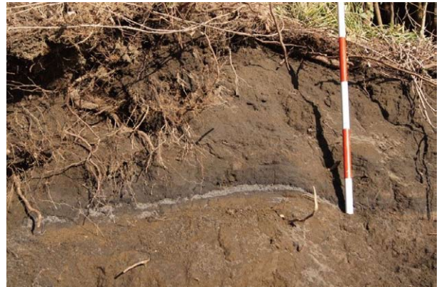
写真-5 崩壊地頭部の滑落崖の状況 (⑤地点) Photo 5 Head of collapsed area of scarp (Site ⑤) 崩壊層は層厚 80 cm の透水性の大きい火山砂層で、下位には透水性の小さなレス層が分布する
