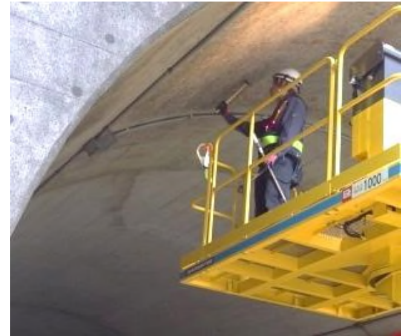
通常の打音検査状況
