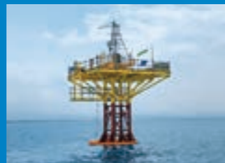
海上ボーリング調査
