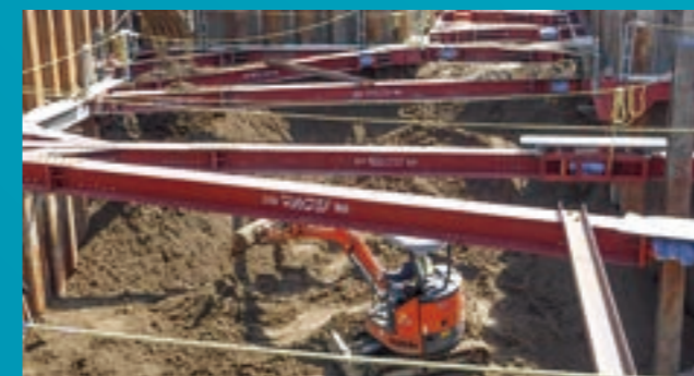
土壌汚染対策工事のイメージ
